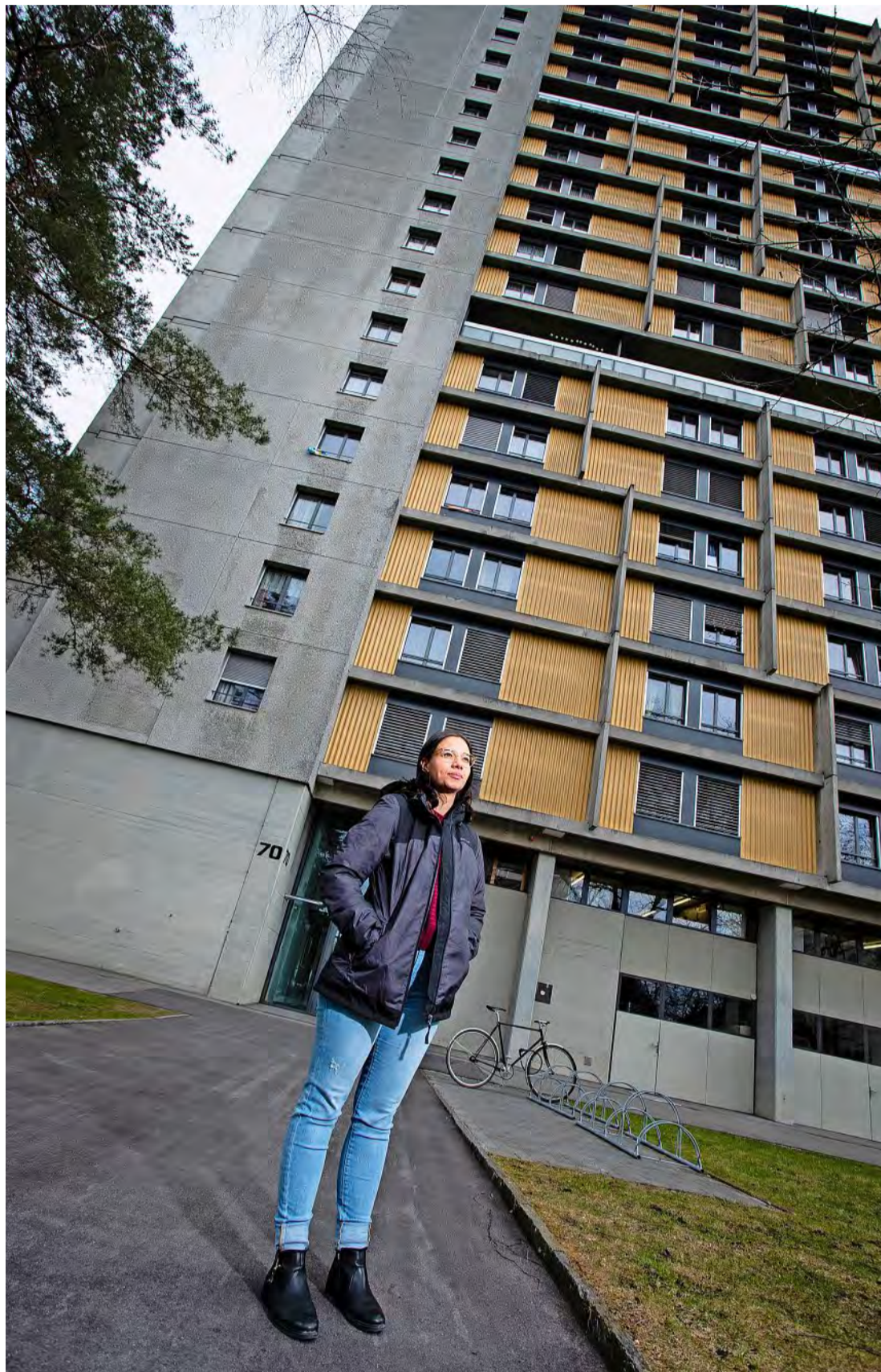
Ramona Wüthrich von der Eisenbahner-Baugenossenschaft vor dem Hochhaus an der Schwabstrasse, in dem ihre Arbeitgeberin 120 Wohnungen vermietet. Foto: Nicole Philipp
